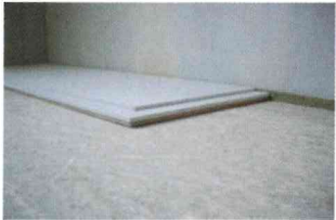
rechtstreeks op bestaande vloer
